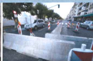
Schéma « type » et exemples d'aménagement d'un dispositif de chicanes de ralentissement
